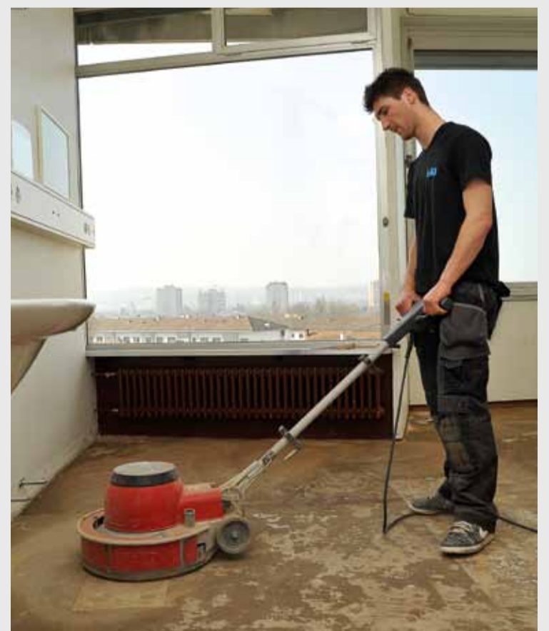
Saniert wird und wurde im FPS an mehreren Orten (Bild vom 7. Stock). Foto mat.
