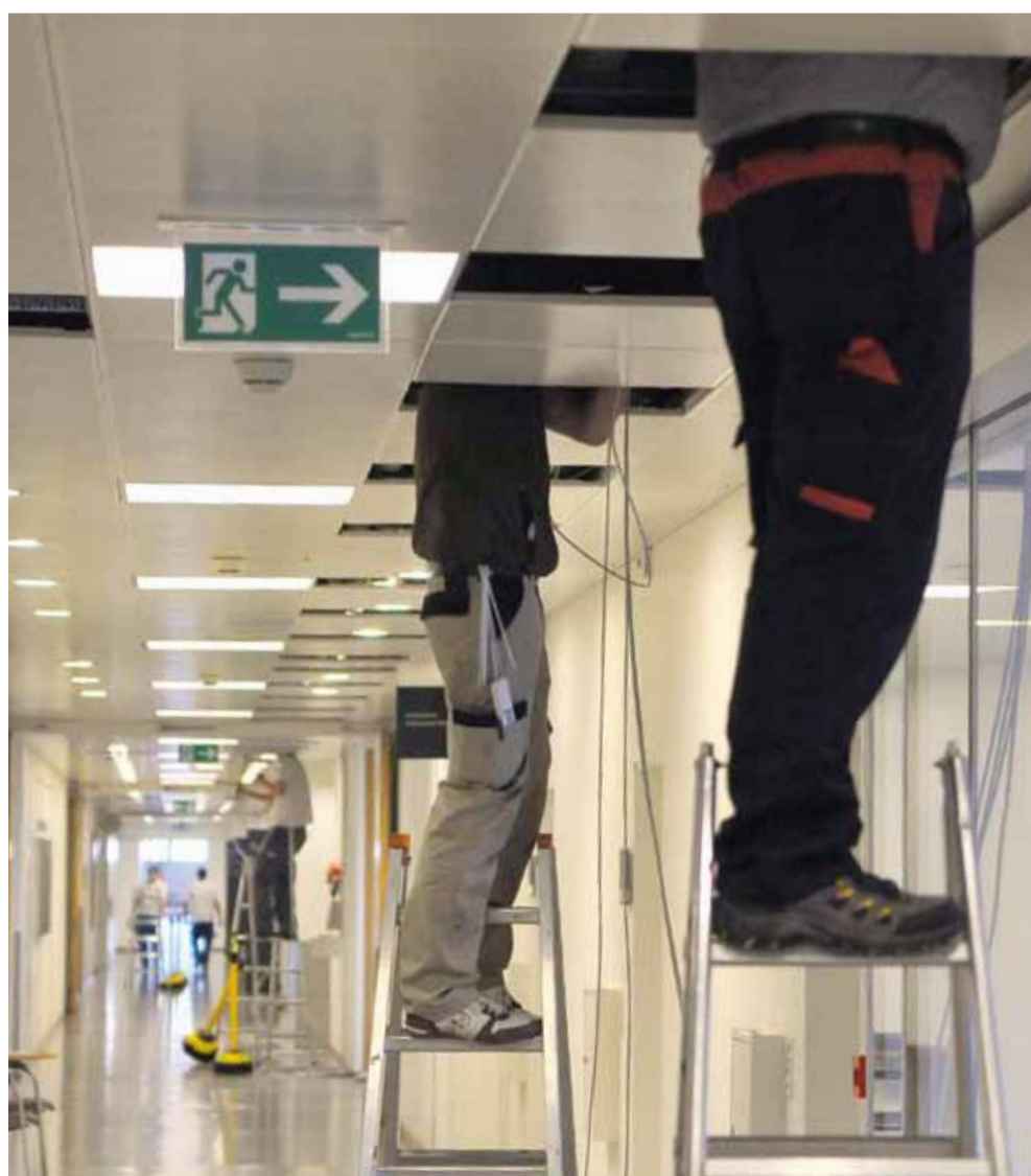
Ein spezieller Schnappschuss von den FPS-Sanierungsarbeiten im Hauptgebäude: Böse Zungen könnten behaupten, in diesem Spital gehe es kopflos zu...
