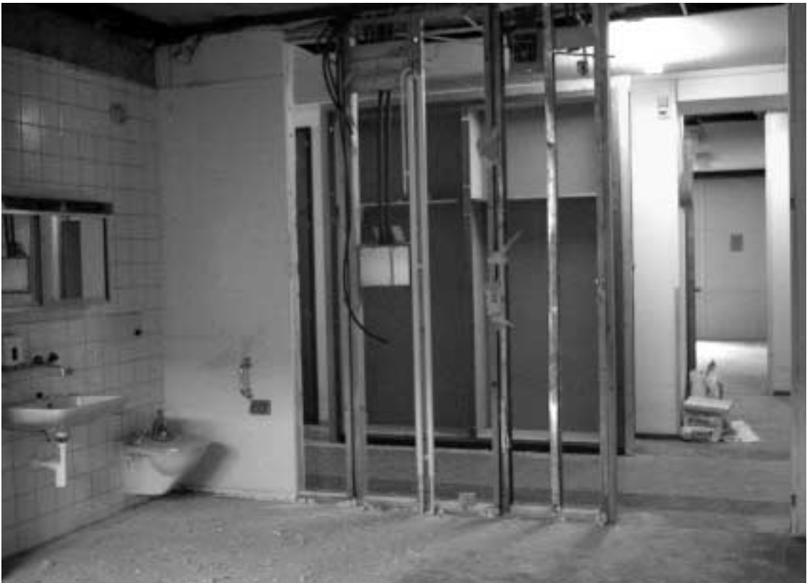
Hier entsteht das neue Wohnheim
