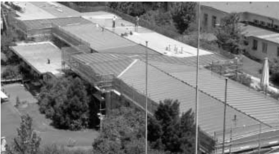
Die Arbeiten auf dem Dach am Gebäude C in vollem Gange
