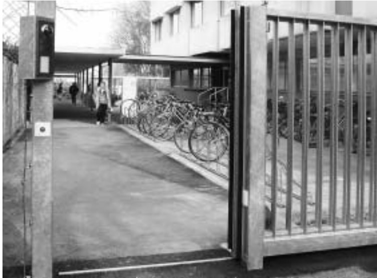
Neues Tor am Arealzugang Hegenheimerstrasse
