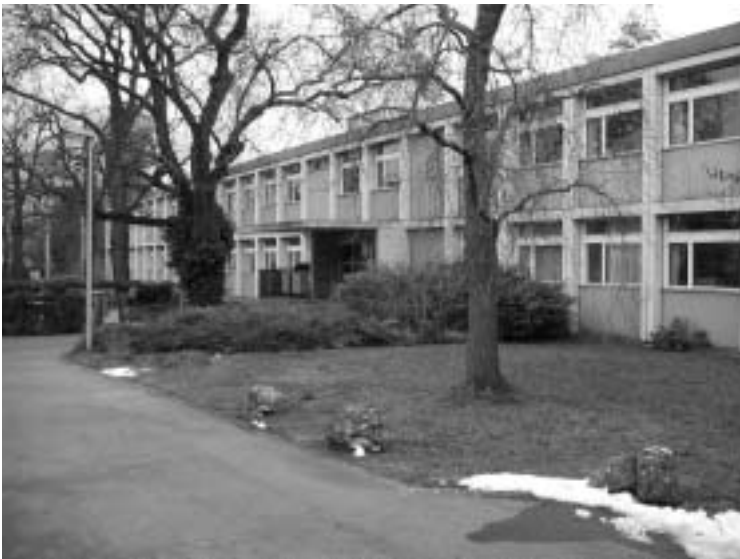
Die Passerelle ist im Gebäude A untergebracht
