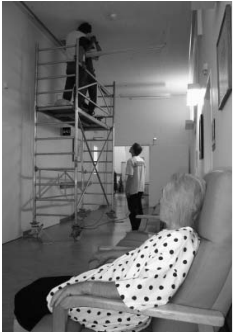
Auch in luftiger Höhe wird gearbeitet
