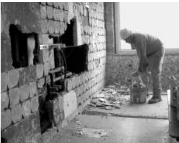
Im Hohlraum hinter der ehemaligen Plättliwand wird die Installation der Lüftung, Heizung, Wasser- und Sauerstoffleitungen sichtbar
